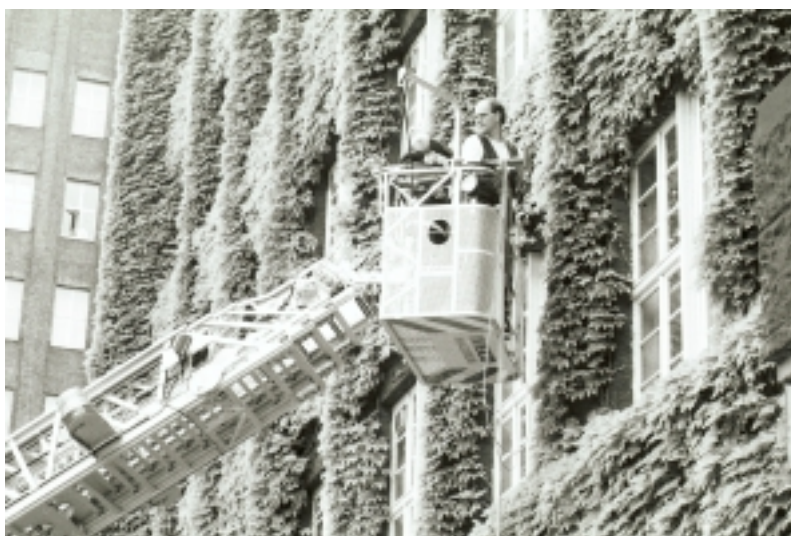
Montage meteorologischer Messgeräte an einer detailliert untersuchten Fassadenbegrünung
