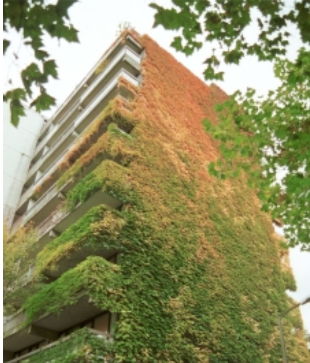
Fassadenbegrünung mit Dreispitziger Jungfernebe ( Parthenocissus tricuspidata ). Begrünungshöhe etwa 30 Meter
